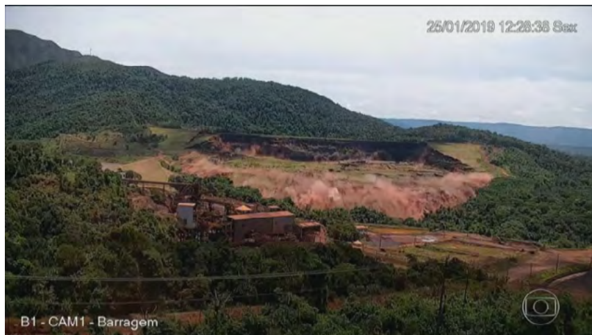
Figura 10.1 - Registro do momento do rompimento da Barragem 1 da Mina Córrego do Feijão da Vale em Brumadinho-MG. Fonte: Jornal Nacional, 2019
