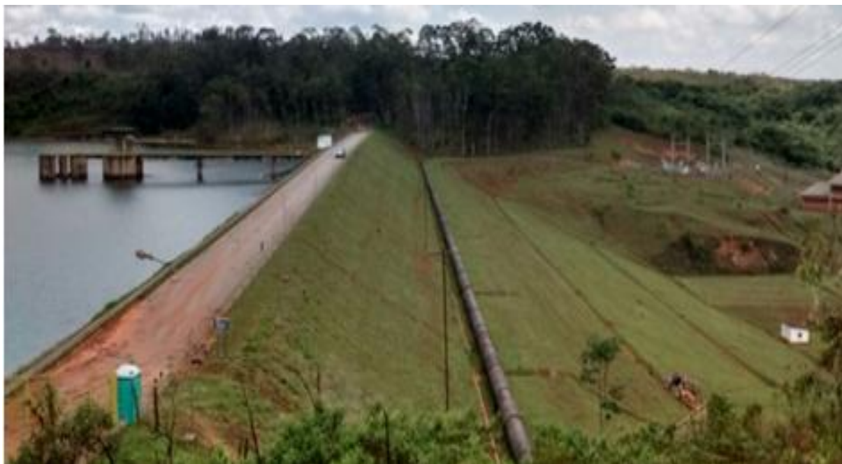
Figura 14: Barragem Lago Soledade (Vista Frontal).
