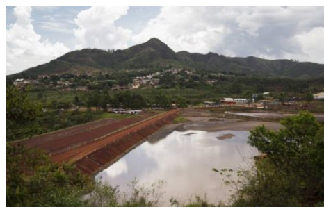
Figura 23: Barragem do Vigia.
