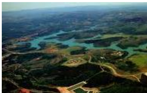
Figura 22: Barragem do Lago Soledade.
