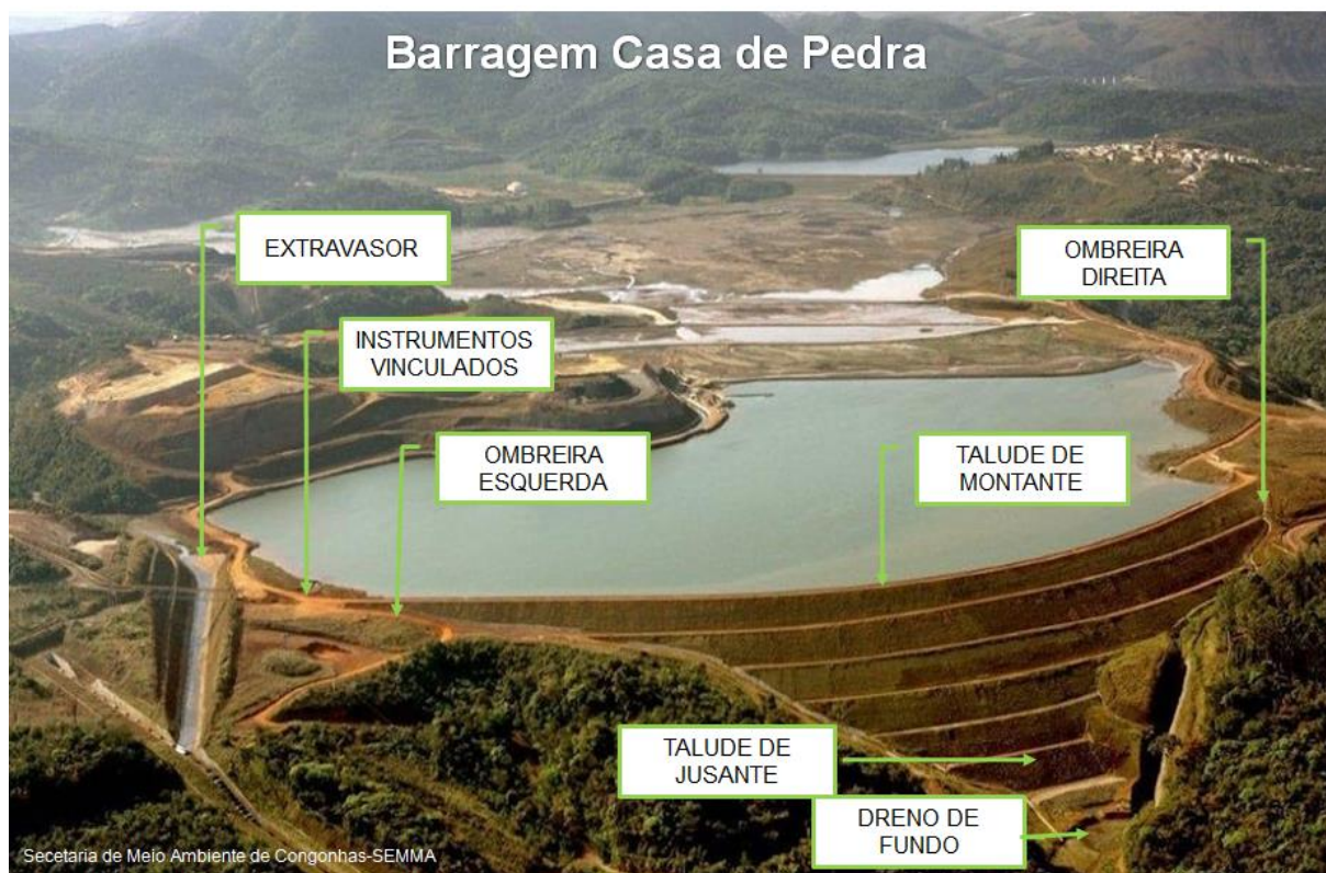
Figura 5: Nomenclatura das estruturas de barragens.
